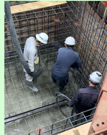
コンクリート打設
